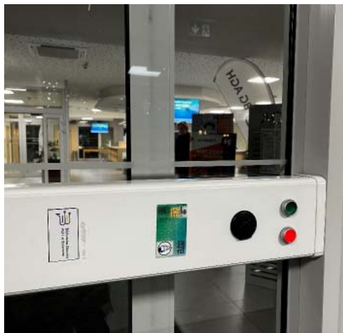
Ilustracja 4. Panel z czujnikiem zbliżeniowym dla legitymacji studenckich uruchamiający wejście i rejestrujący odwiedziny w BG AGH w Krakowie
